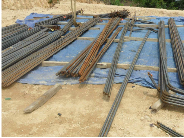
철근 임시 보관 상태
